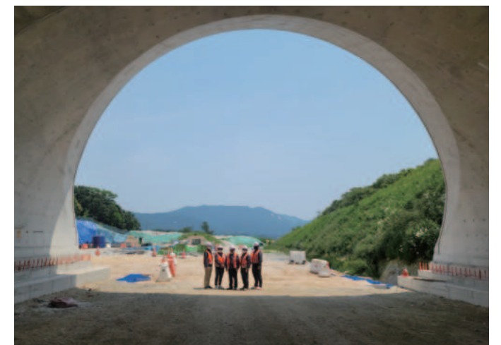
파주-포천 고속도로 건설공사(은현3터널)
