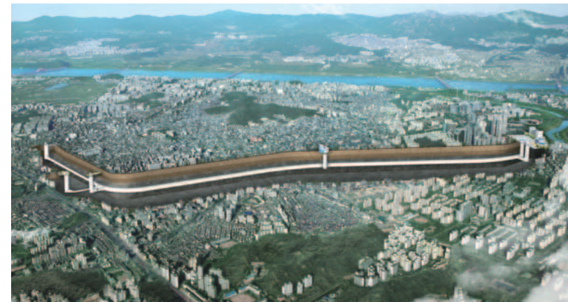
신월 빗물저류 배수시설(터널)
